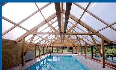
CLIMAX : toiture complète sur mesure livrée en kit, profilés autoportants à rupture thermique.
